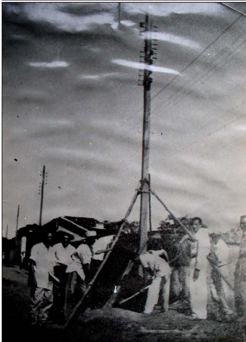
Fincamento dos primeiros postes de energia elétrica (A direita o Prefeito Joca Costa)
